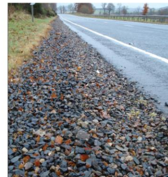
Esempio di dreno filtrante lungo una carreggiata stradale
